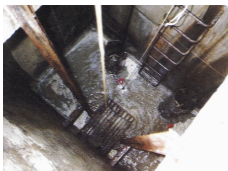
Station de relevage en cours de traitement
